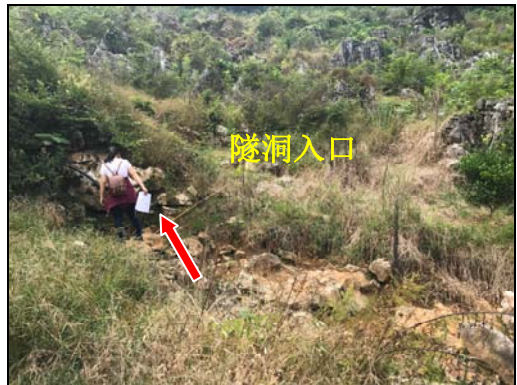
引水隧洞入口
